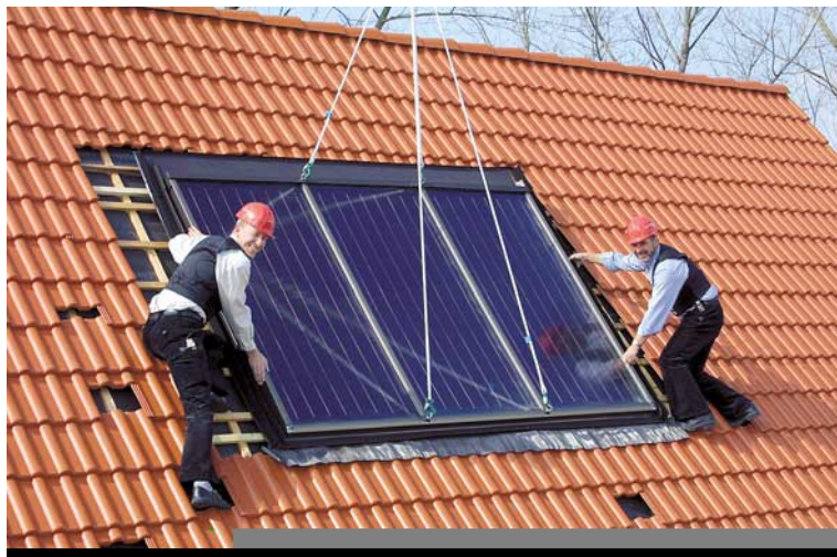
← Montage eines Thermokollektors TK 6 mit dem Hochkranservice zum Festpreis. Im Normalfall bedarf es keines Installateurs auf dem Dach.
